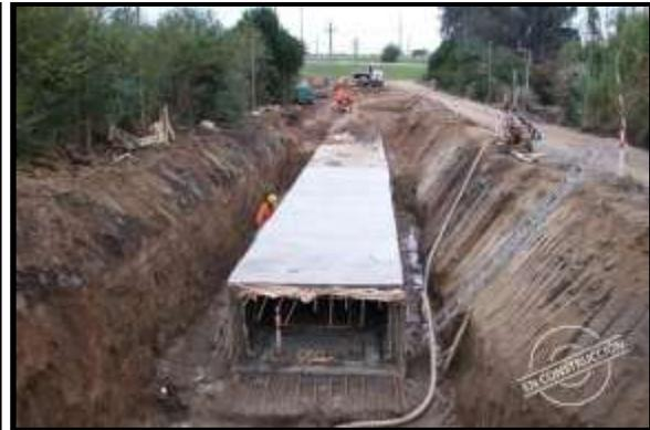
• Fig. 5.2 Colector pluvial, construcción. Fuente Sistema Hidráulicos
