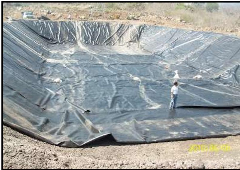
• Fig.5.5 Ejemplo de bordo de almacenamiento. Fuente Sistema de almacenamiento pluvial
