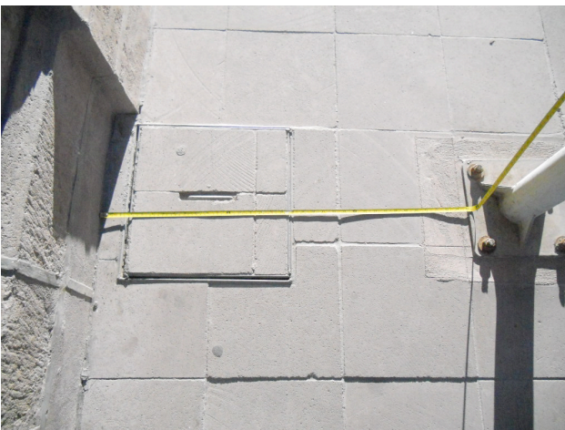
IMAGEN 5. OBSTÁCULOS EN VIALIDAD PEATONAL, CALLE GENERAL FUERO, TRAMO CALZADA DE GUADALUPE Y 5 DE MAYO, S. L. P., 2012.
