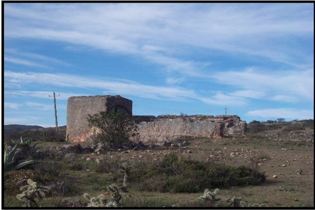
Figura 2. 17. Antiguas instalaciones de haciendas de beneficio de mercurio en San Antonio, Guadalcázar, San Luis Potosí.
