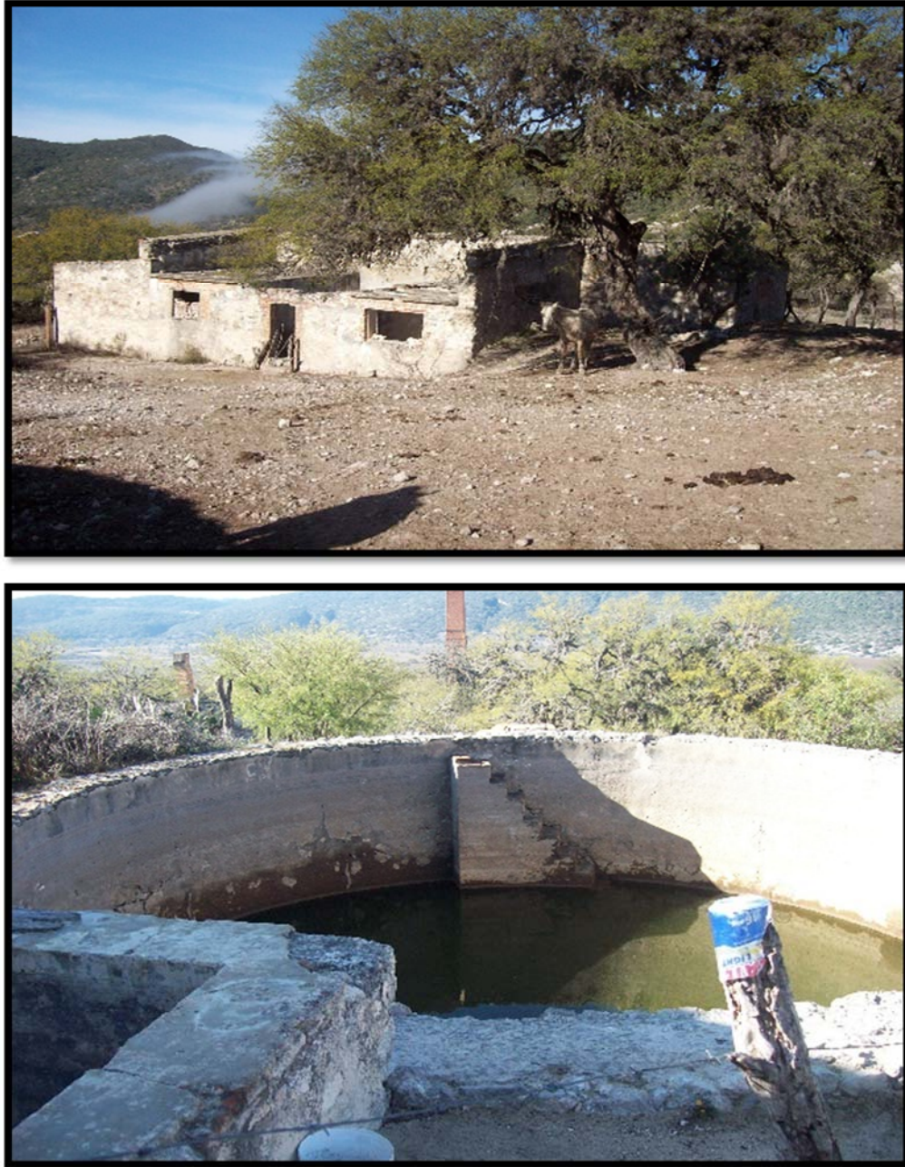
Figura 2. 11. Instalaciones de ex hacienda de beneficio de mercurio en La Trinidad, Guadalcázar.
