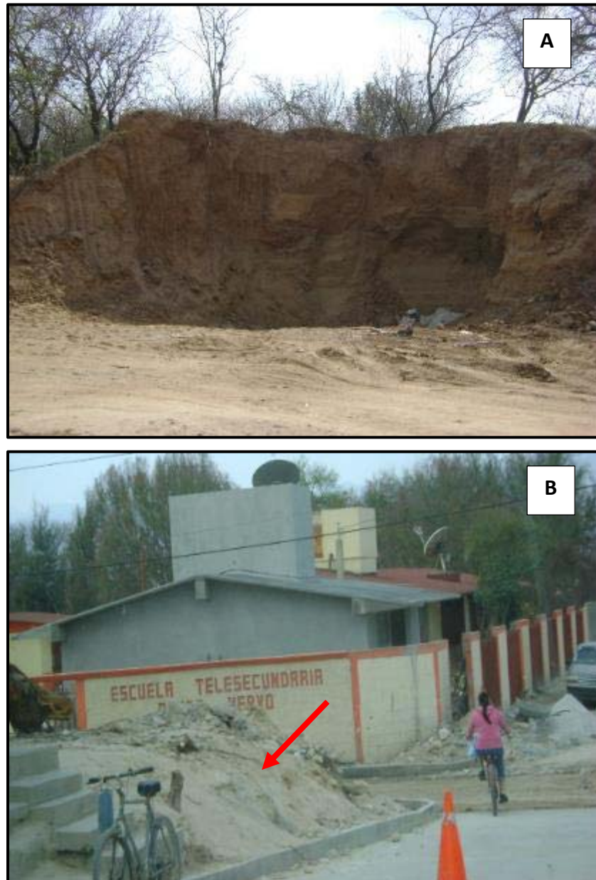
Figura 3. 16. (A) Evidencia de material de residuo removido mediante maquinaria; (B) jales de amalgamación reprocessados han sido empleados en la construcción (notar flecha roja).
