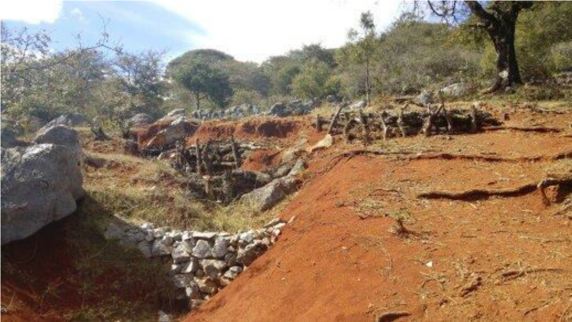
Fotografía 2.15. Presencia de obras de conservación de suelo, construidas con financiamiento gubernamental, con la finalidad de minimizar el impacto de erosión de suelos.
