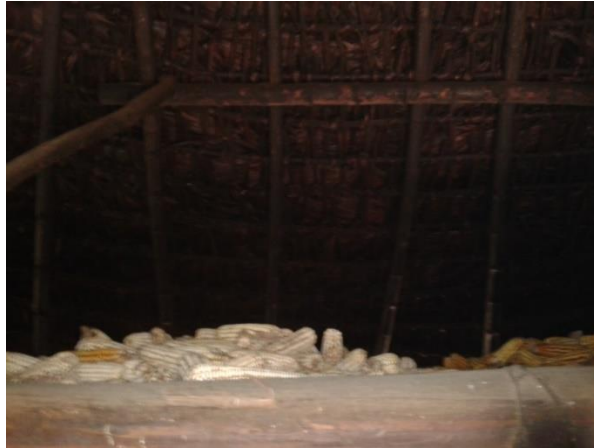
Tapancos o doble altura en las casas. Enero de 2014.
