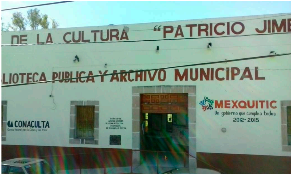
Imagen 8. Fachada del Archivo del Municipio de Mexquitic de Carmona.
