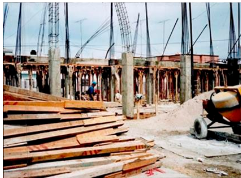
Fotografía 7. Construcción del Centro de Información. Fuente archivo fotográfico de la BECENE. Año 2003
