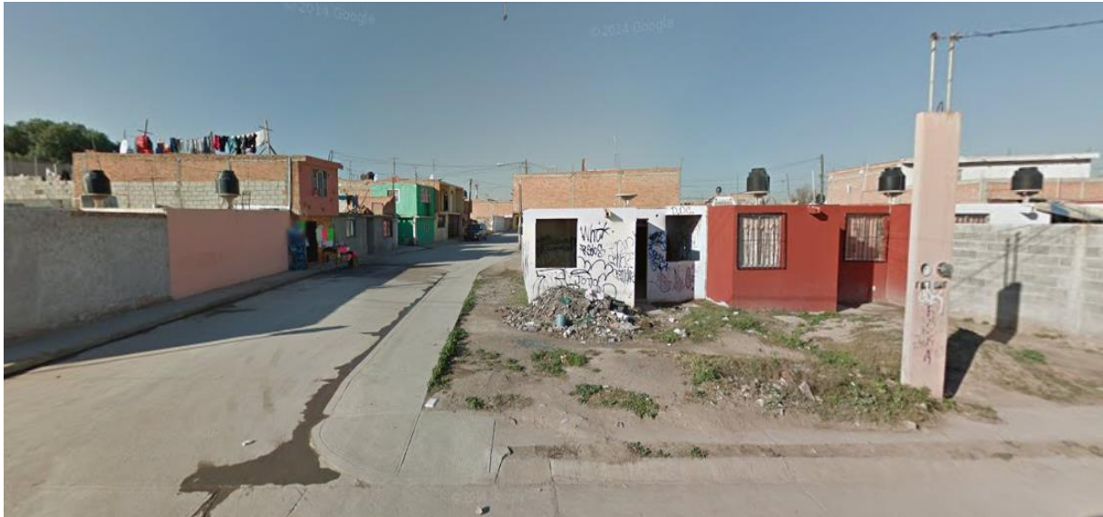
Vivienda destruida y grafitada en el fraccionamiento Valle de San Jose.
