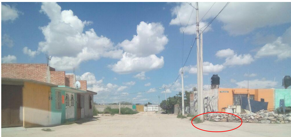
En la imagen se puede apreciar que, si existe la rampa para sillas de ruedas, pero no está señalizada.
