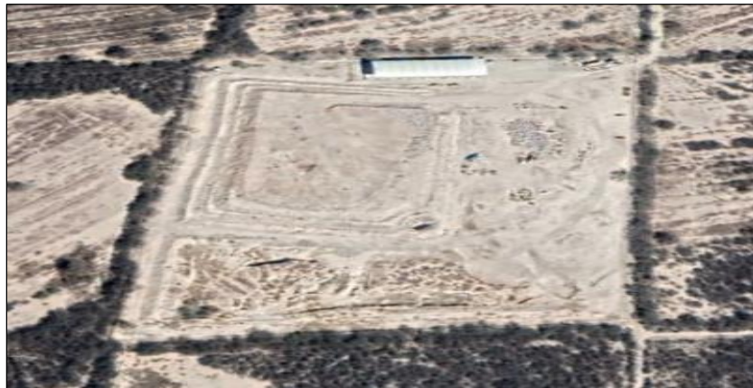
Figura 3.2. Ubicación de tiradero controlado a cielo abierto en el municipio de Matehuala, San Luis Potosí.
