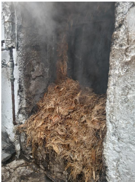
Figura 19. Bagazo como combustible para caldera, Laguna Seca, Charcas.
