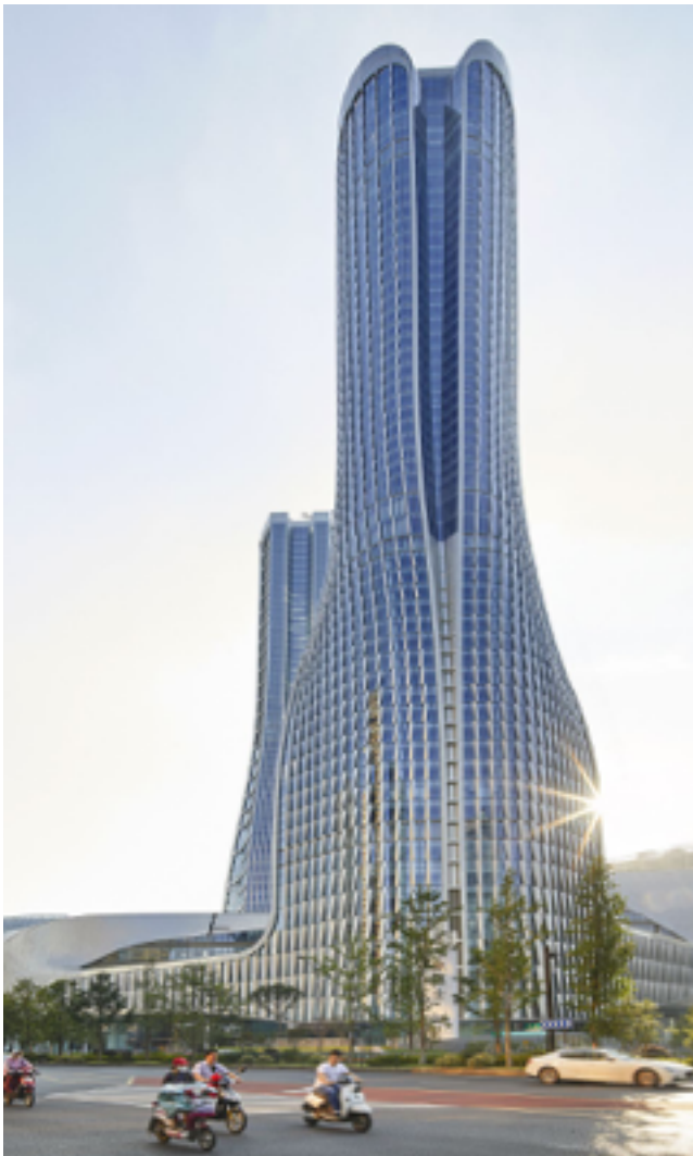
Ilustración 72. Vista exterior. Fuente: https://www.unstudio.com/
