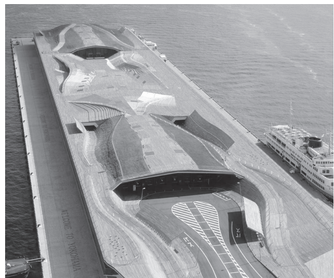
Ilustración 55. Vista aérea del complejo. Fuente: http://azpml.com/#/?q=terminal%20yokohama
