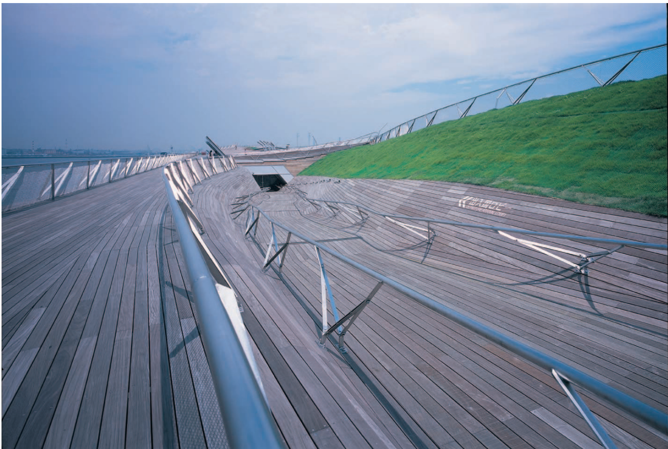
Ilustración 58. Plataforma exterior. Fuente: http://azpml.com/#/?q=terminal%20yokohama
