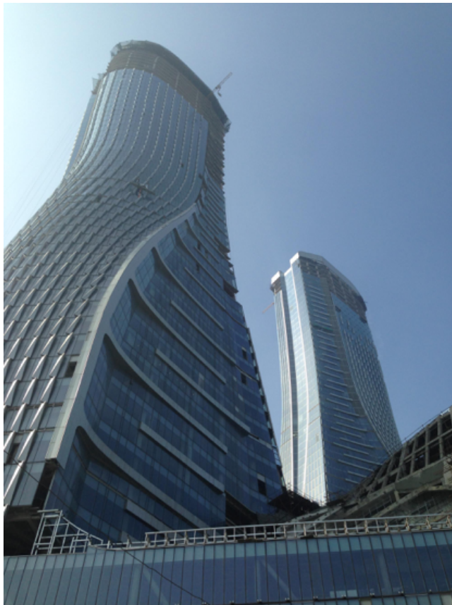
Ilustración 75. Vista de las torres en conjunto. Fuente: https://www.unstudio.com/
