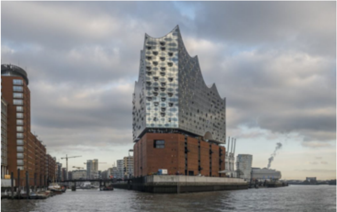
Ilustración 155. Vista panorámica desde el puerto de la Filarmónica del Elba. Fuente: https://www.herzogdemeuron.com/index/projects/complete-works.html
