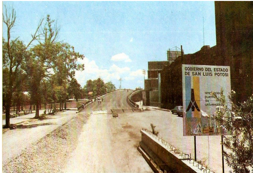
Imagen 18 Ampliación del puente Av. Universidad en 1985. Se puede observar la vegetación de la Alameda aún en los bordes exteriores de su perímetro que actualmente no existe. A la derecha el muro lateral del templo de San José. Vista hacia el oriente de Av. Universidad. Tomada de Imágenes Históricas de San Luis Potosí (2015).
