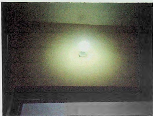
Imagen #17. Tipo de iluminación que se encuentra en el depósito
