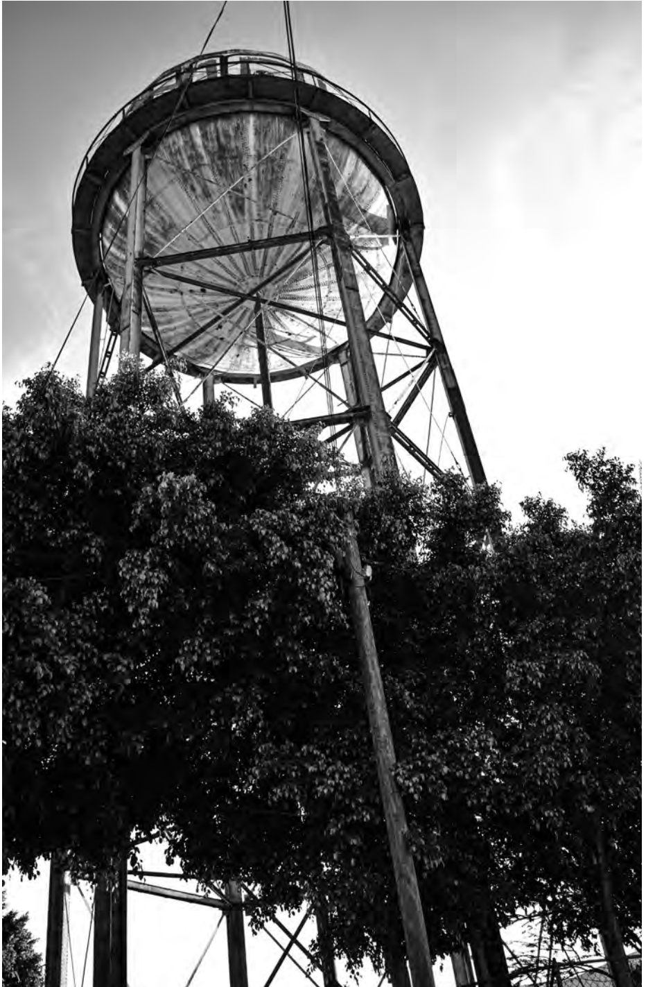
Calle Aquiles Serdán con avenida Damián Carmona ■ Barrio de Santiago, San Luis Potosí
