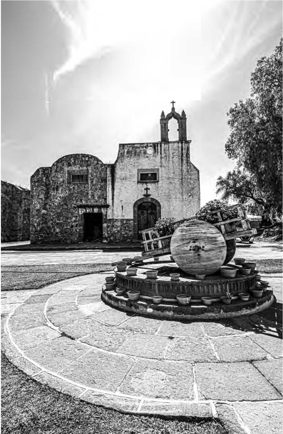
■ Ex hacienda de Arroyos Comunidad de La Pila, San Luis Potosí
