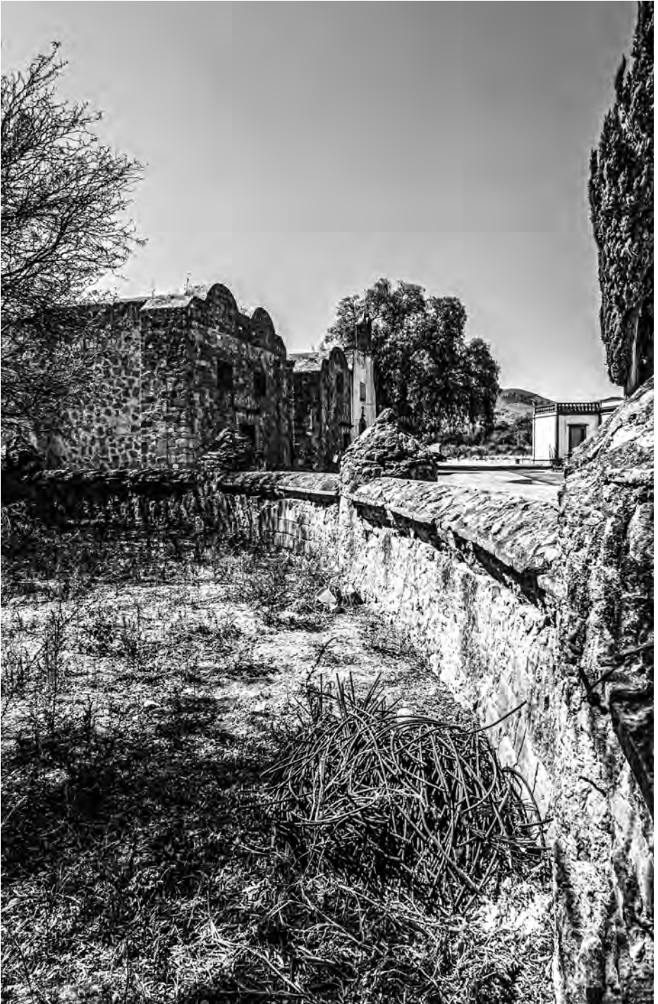
Ex hacienda de Arroyos ■ Comunidad de La Pila, San Luis Potosí
