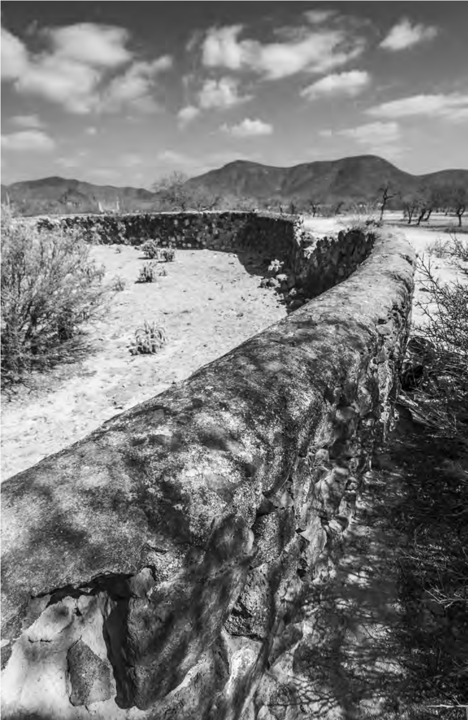
■ Barda perimetral Ciudad del Maíz, San Luis Potosí
