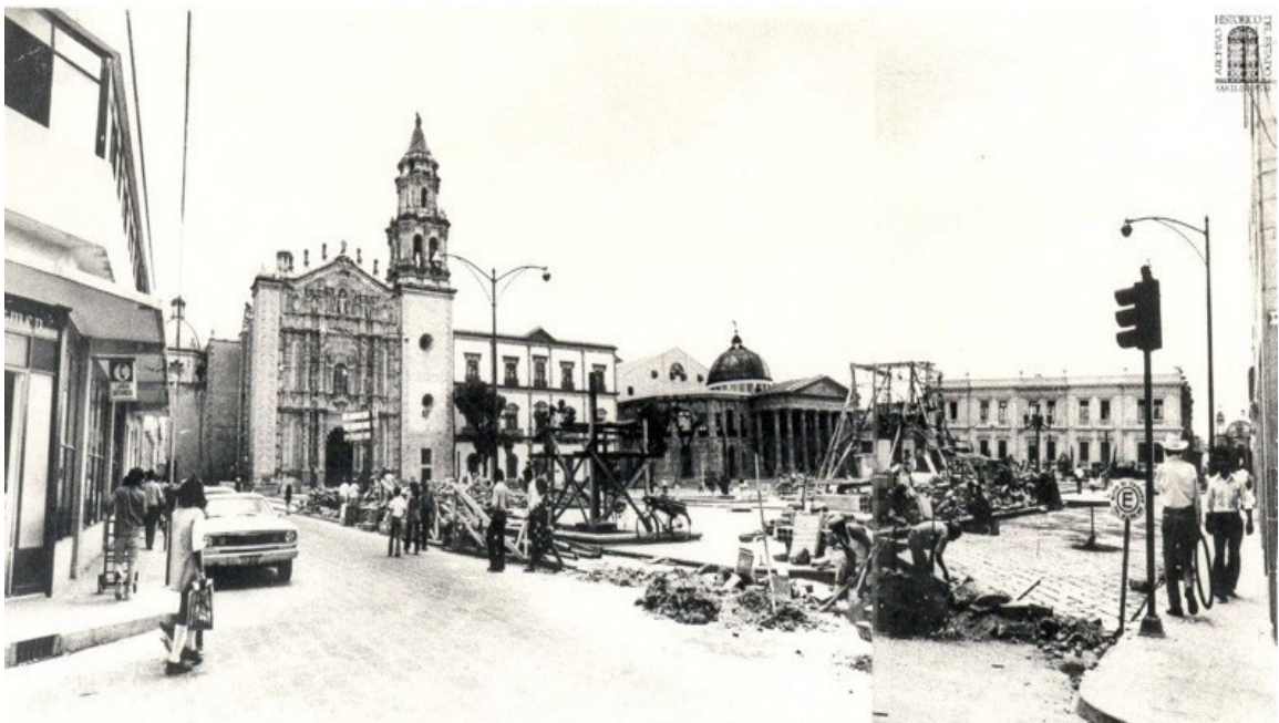
Figura 12. Albañiles trabajan en la remodelación de la Plaza del Carmen, se observa el Convento de los Carmelitas AHESLP 2023
