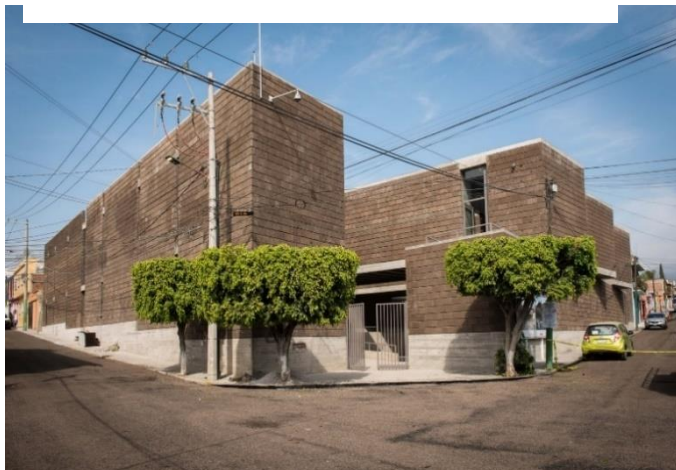
IMAGEN 42. FACHADA DEL CENTRO DE DESARROLLO LOS CHOCOLATES. El tipo de acabado es concreto aparente y sillar
