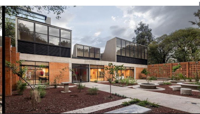
IMAGEN 45. PARTE EXTERIOR POR FRENTE.
