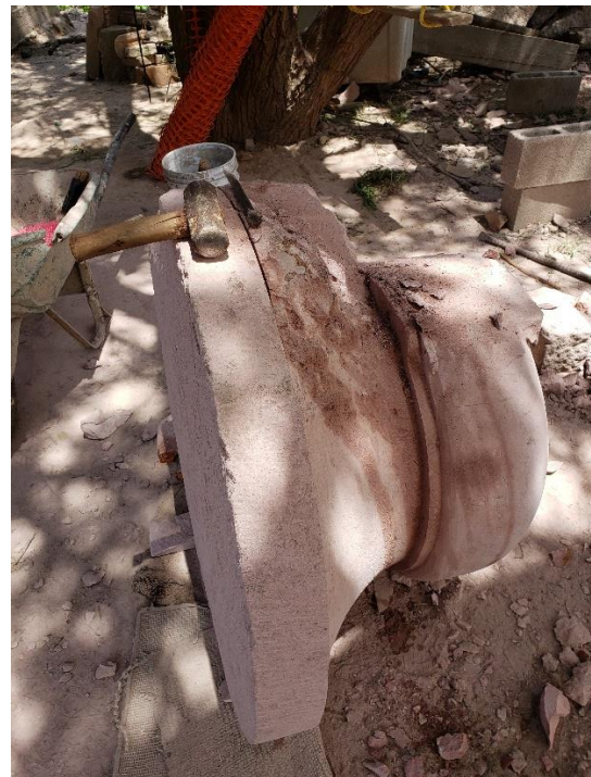
Figura 18. Trabajo de forma y detallado para base de columna. Fotografía JPPG
