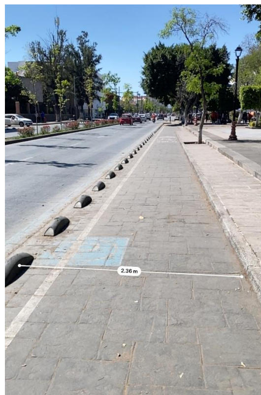
Ilustración 36.-Ciclovía segregada Av. Venustiano Carranza. Fuente: Autor
