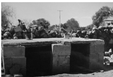
Construcción de la loza sobre los dos depósitos.
