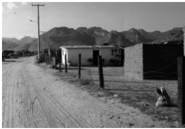
Calle principal electrificada de La Presita.
