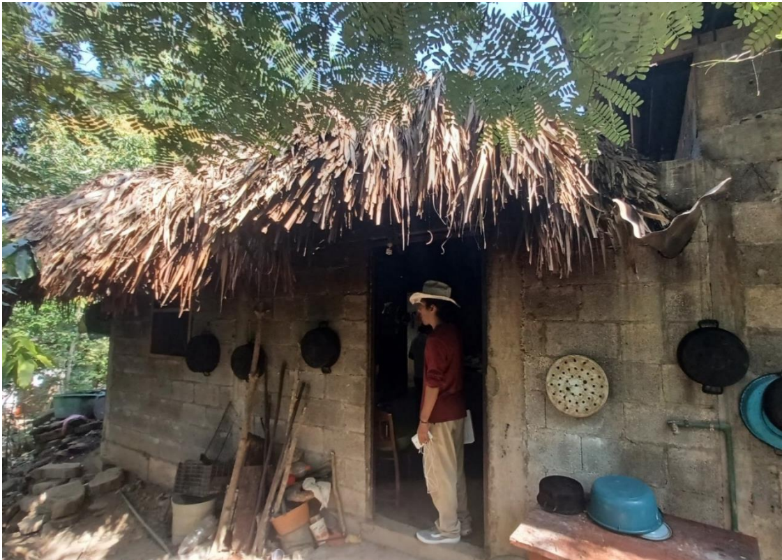
Ilustración 41. Vivienda 3 híbrida. Techumbre vivienda 1. Foto por el autor.
