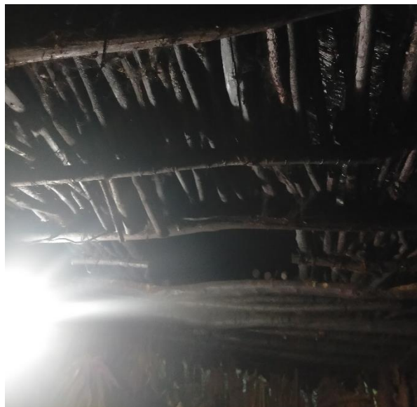
Ilustración 40. Techumbre vivienda. Techumbre vivienda 2. Foto por Irbin Andrade.
