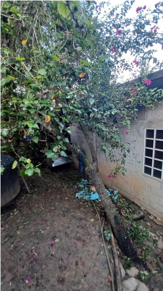
Ilustración 45. Exterior vivienda 4. Foto por el autor.
