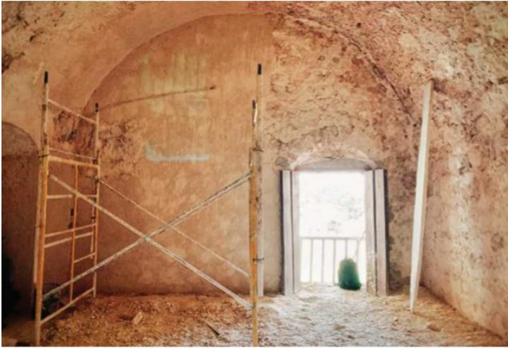
Imagen 2 Aplicación de mortero con agua de chukum en muros y bovedas, Pacheco, P. (2019)
