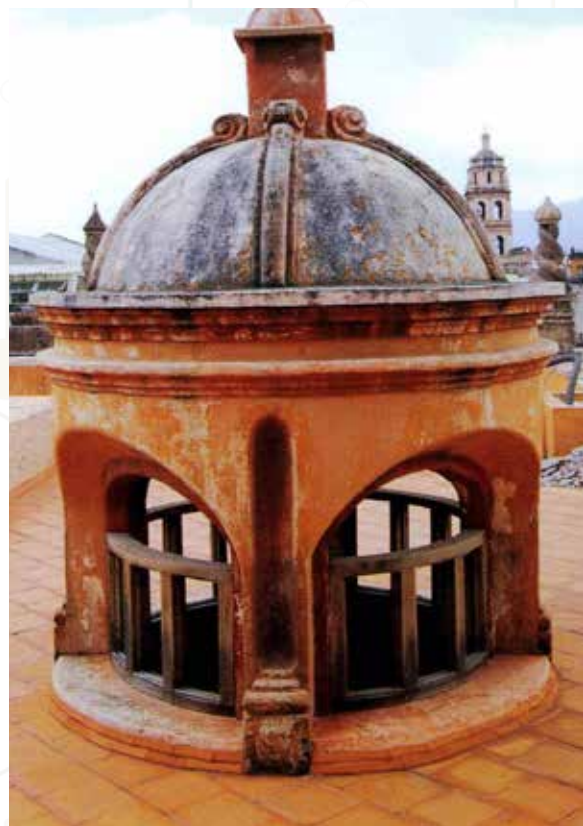
Contraportada . Linternilla de la Caja Real.
