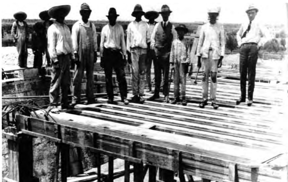
Construcción de la Planta Potabilizadora "Los Filtros" año 1926
