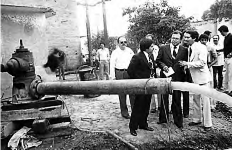
Perforación de pozo profundo, 1970
