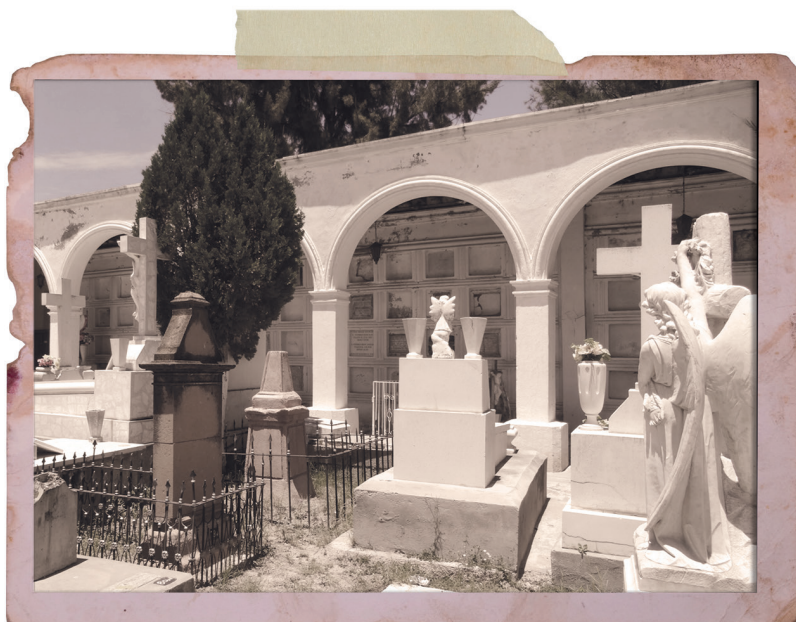
• Panteón Hidalgo, muro de criptas
