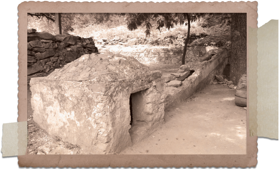
• Cárcamo y acequia
