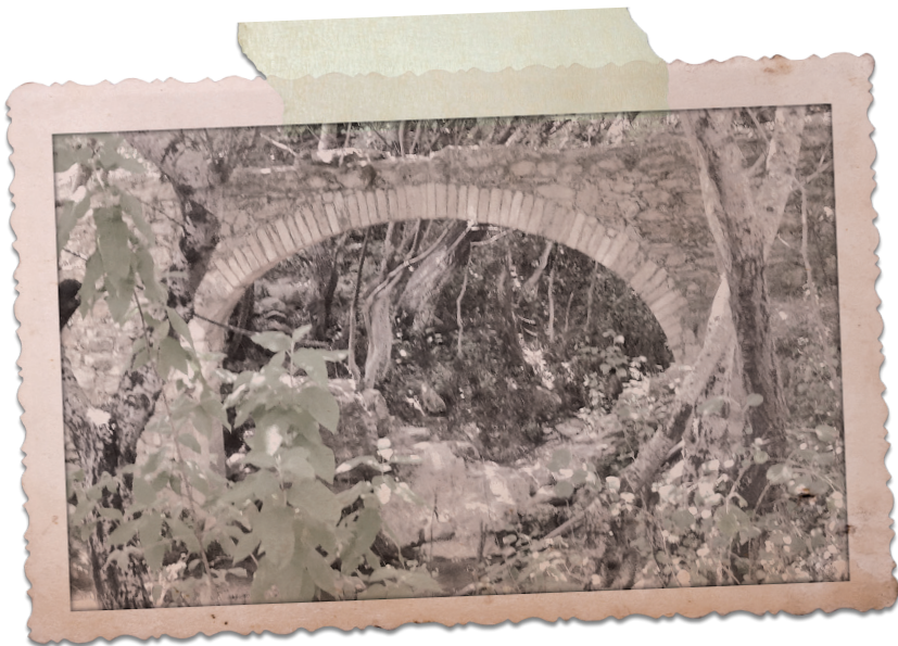
• Arco del acueducto
