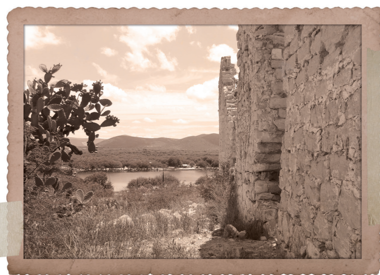
• Imágenes de la Casa del Administrador o del Cerrito Blanco
