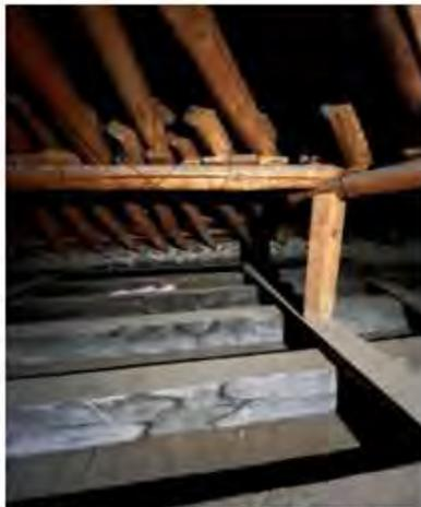
Imagen No. 4.2 Gualdra de madera sobre plafón y estructura de madera en cubierta, Fuente: archivo propio, 2024
