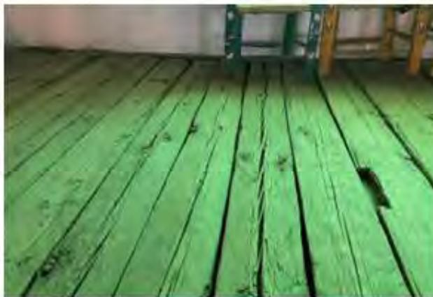
Imagen No. 4.11 Estructura de madera en coro (piso).
