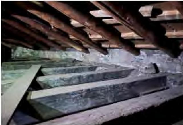
Imagen No. 4.4 Gualdra de madera sobre plafón y estructura de madera en cubierta, Fuente: archivo propio, 2024
