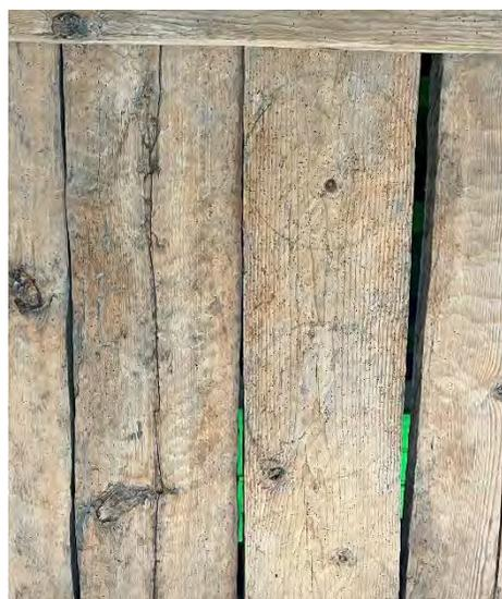
**Imagen no 3.10-** Vista de elementos de madera en cubierta de sotocoro con presencia de polilla
