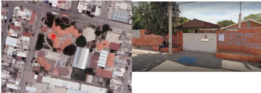
Imagen 38. Escuela Ford 104, Vista aérea y fachada principal. Río Verde, Ignacio Zaragoza 918, Col. San Antonio. Fuente: Googlemaps e imagen del autor
