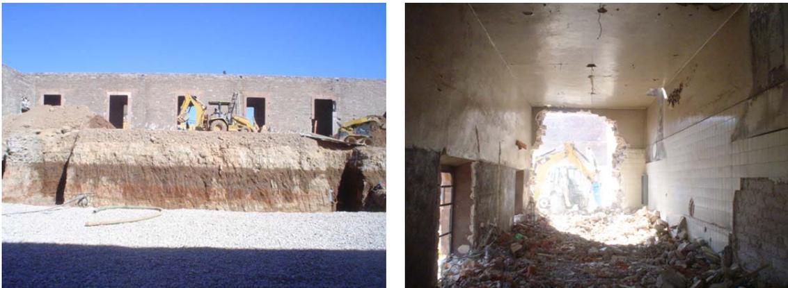
Fig. 27, 28, Proceso de excavación y demolición de preexistencias para la construcción del Teatro.<sup>123</sup>
