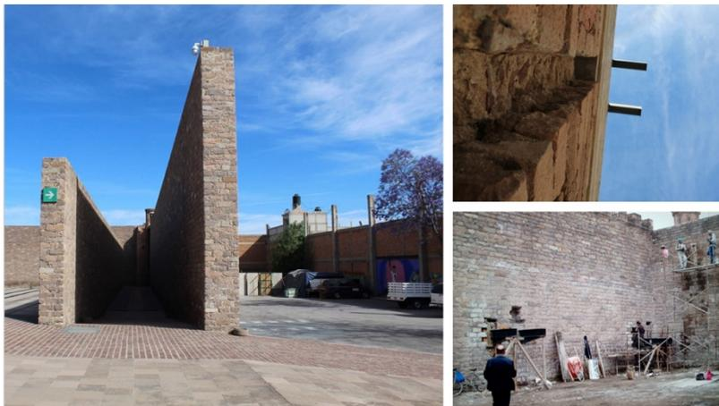
Por otra parte, se añadieron muros falsos de prefabricado de yeso al fondo de cada célula con la finalidad de tapiar los vanos originales impidiendo el ingreso de luz solar con motivos
